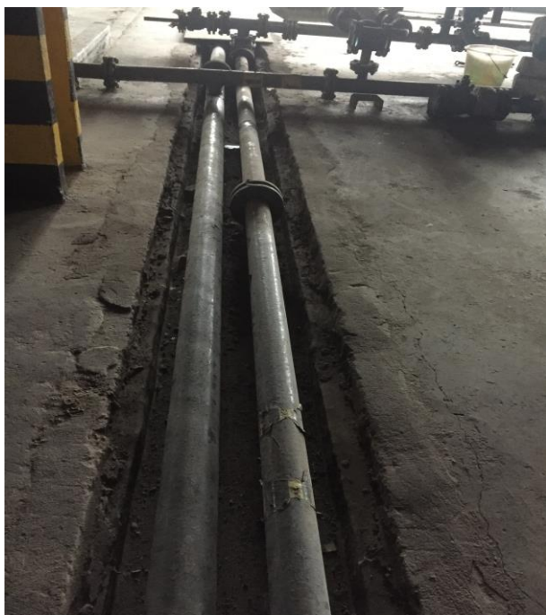
车间生产装置区设导流沟并进行防渗防腐处理
