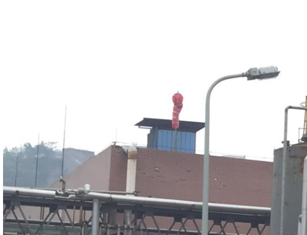
厂区高处设风向标
