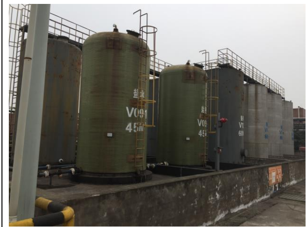
储罐区（罐组一）设置围堰并进行防渗防腐处理
