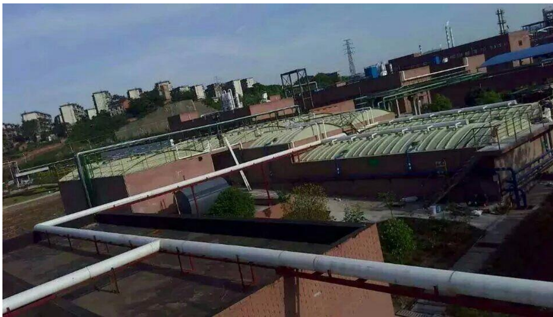
图 4.3 废水处理站设置情况图
