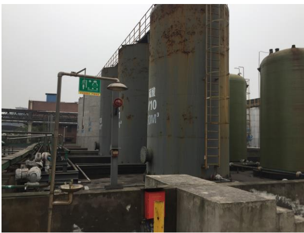
储罐区（罐组二）设置围堰并进行防渗防腐处理
