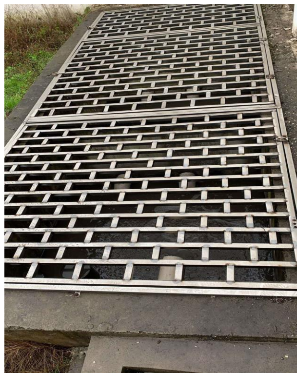
设置三段式隔油沉砂池
