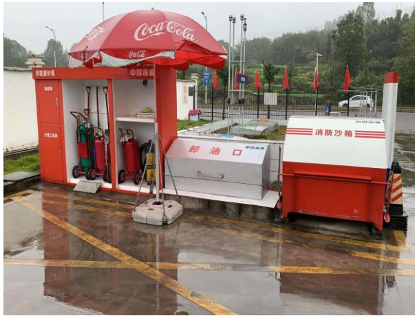
卸油区旁配备应急物资
