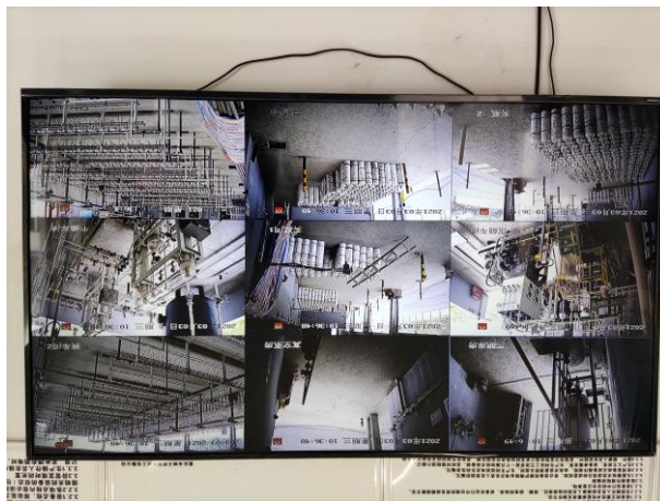
控制室内设视频监控屏
