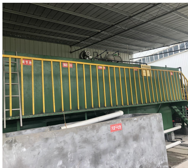
污水处理站防腐、防渗处理
