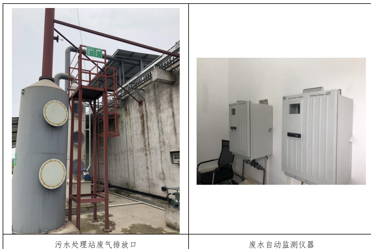
图 4.7 建设项目排放口设置情况图
