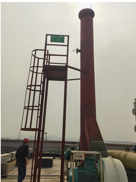
工艺废气排放口
