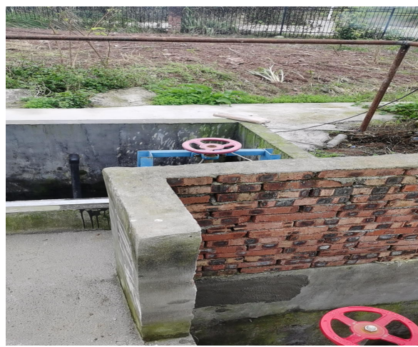
初期雨水收集池
