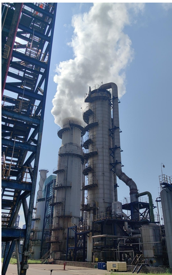
转化炉废气排气筒
