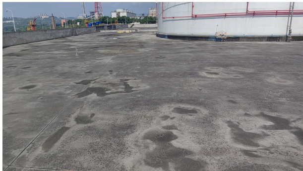
成品罐区地面防渗
