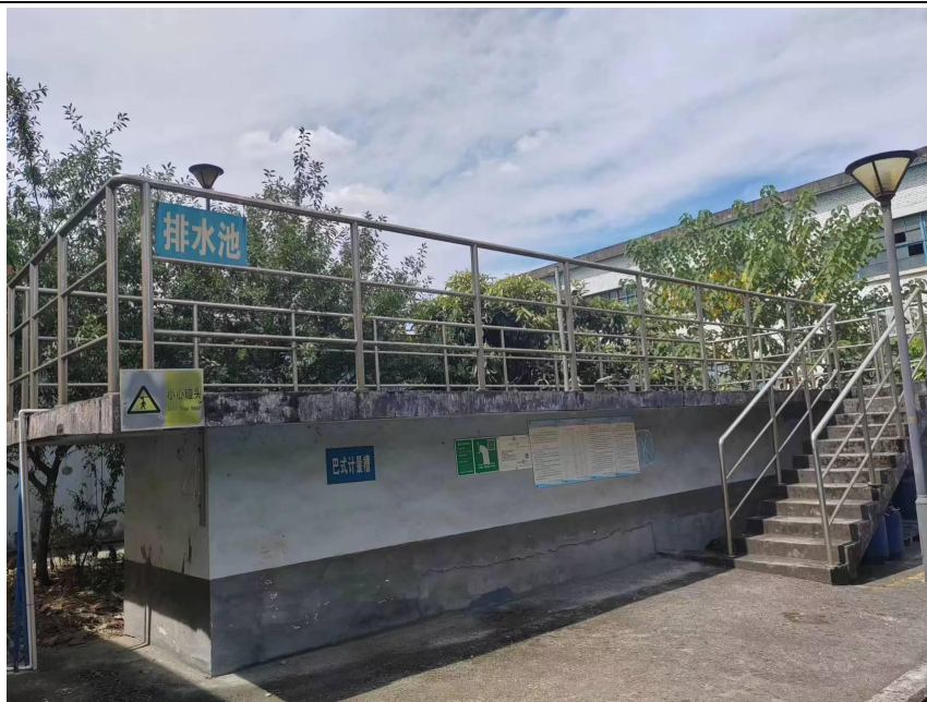
废气排放口设置情况图
