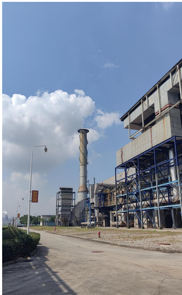
CO 2 吸收塔废气排气筒
