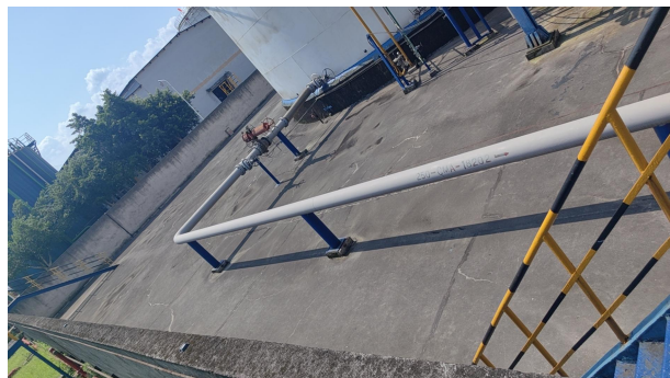
中间罐区地面防渗
