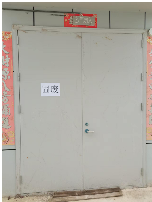
一般固废暂存间
