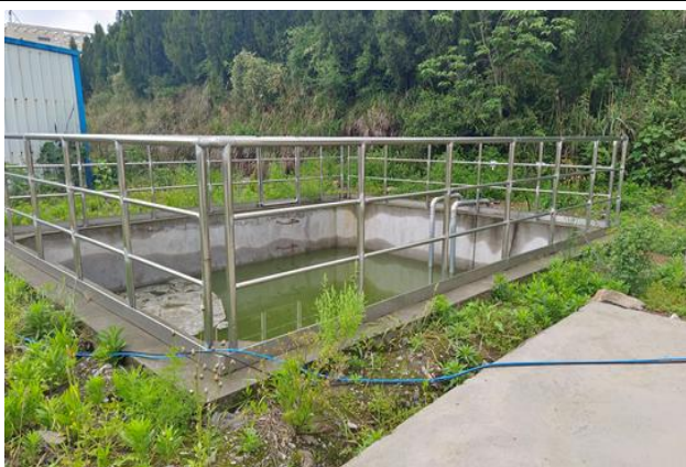
项目片区事故废水收集池（120m 3 ，依托）
