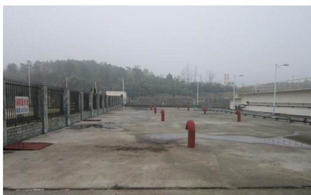
消防废水收集池（依托）
